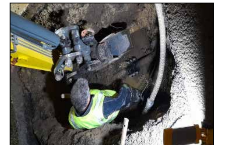
Réparation d'une fuite importante en urgence rue Hohbuhl, de nuit.
