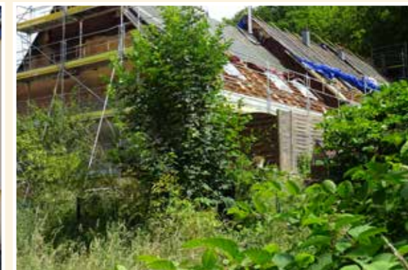
Travaux de rénovation Lotissement rue Verte Voie
