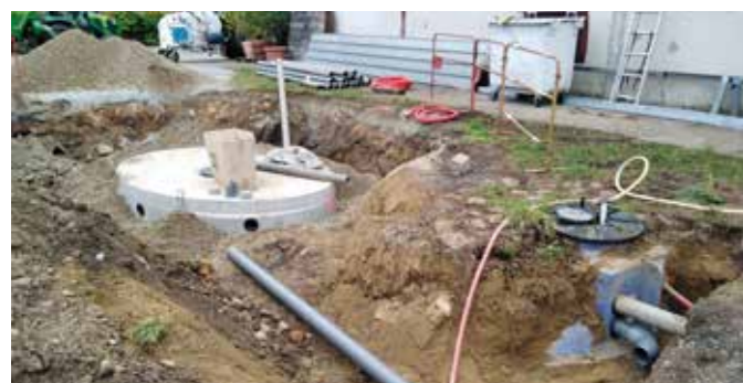
Raccordement au puits d'infiltration
