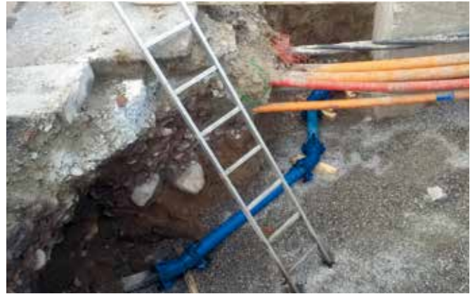
Mise en sécurité de la nouvelle vanne dans le bâti existant avec modification de l'alimentation.
