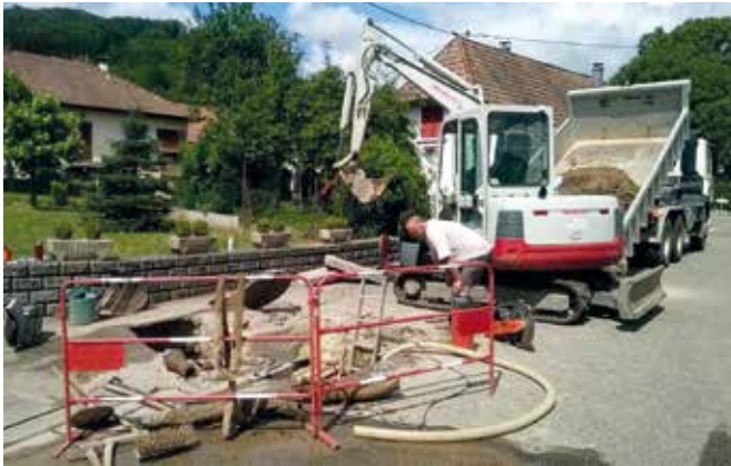
Changement de la vanne de régulation rue du Village.
