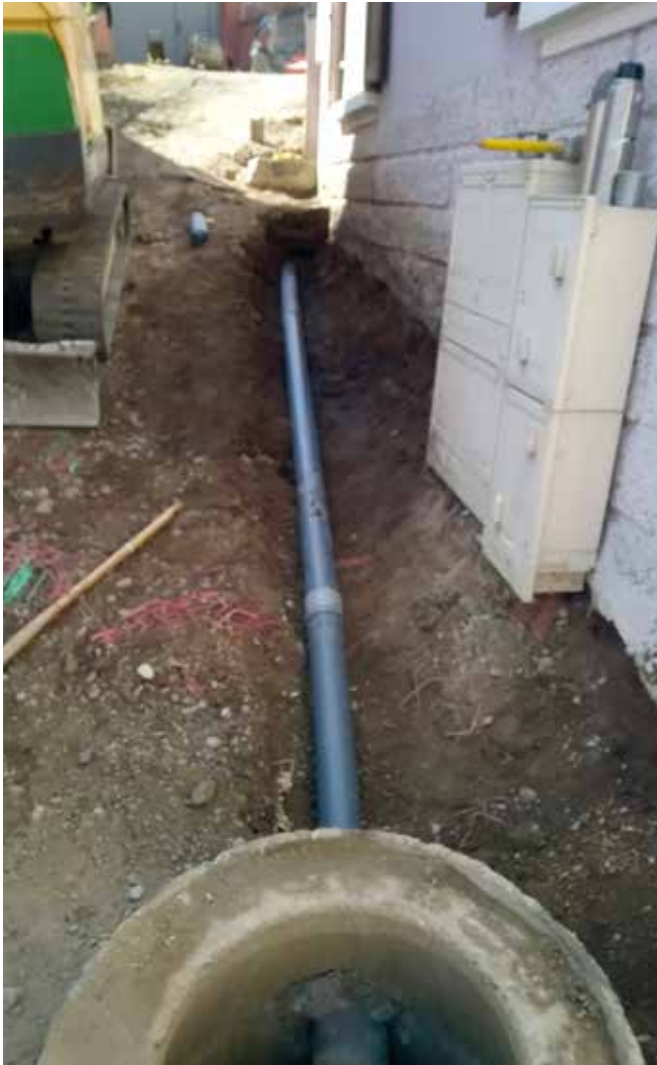
Rue du Moulin – Réfection de voirie et changement de canalisation d'évacuation d'eau
