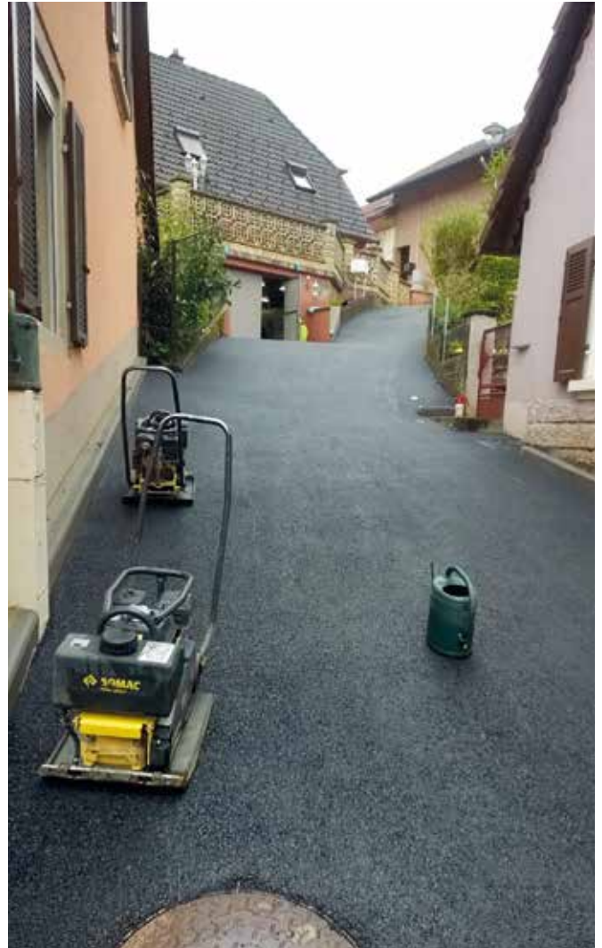
Rue du Moulin – Réfection de voirie et changement de canalisation d'évacuation d'eau
