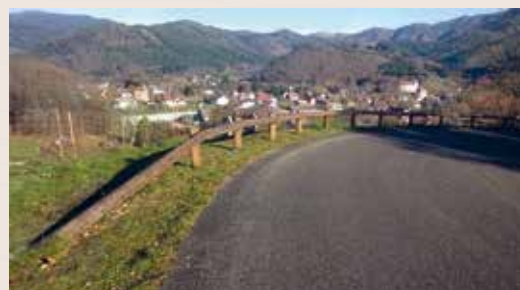
Sécurisation : indispensable dans ce virage.
