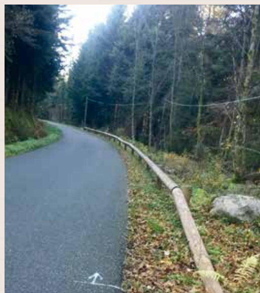
Barrierage : route du Lachtelweiher protection de la ressource en eau.
