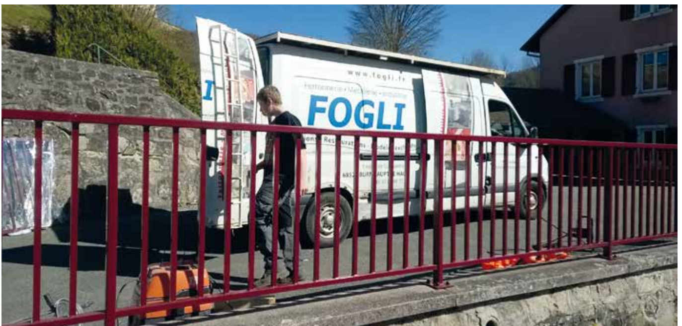
Pose de 3 portails à l'école élémentaire
