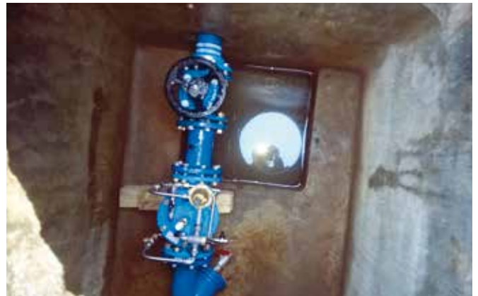
Mise en sécurité de la nouvelle vanne dans le bâti existant avec modification de l'alimentation.
