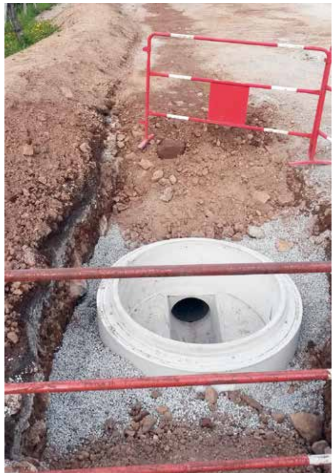
2 ème étape, mise en place de la conduite d'évacuation des eaux de pluie et de ruissellement, ainsi que des regards de collecte, qui sont équipés de grilles en fonte de haute résistance.
