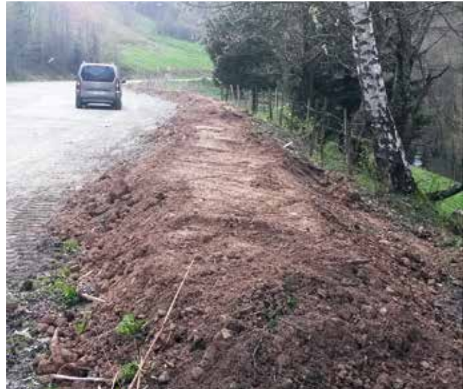
1 ère étape mise en place d'un talus de terre, qui sera laissé en attente quelques mois avant mise en forme définitive, pour stabilisation.
