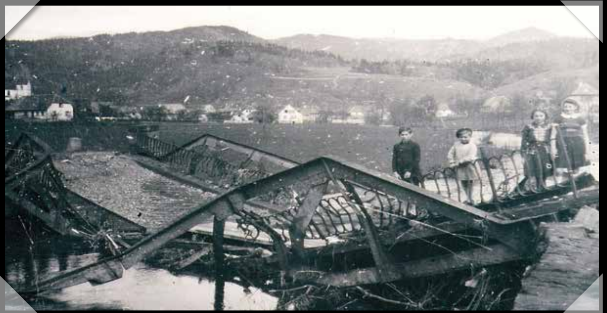
Le même pont après son dynamitage par l'armée allemande en novembre 1944.
