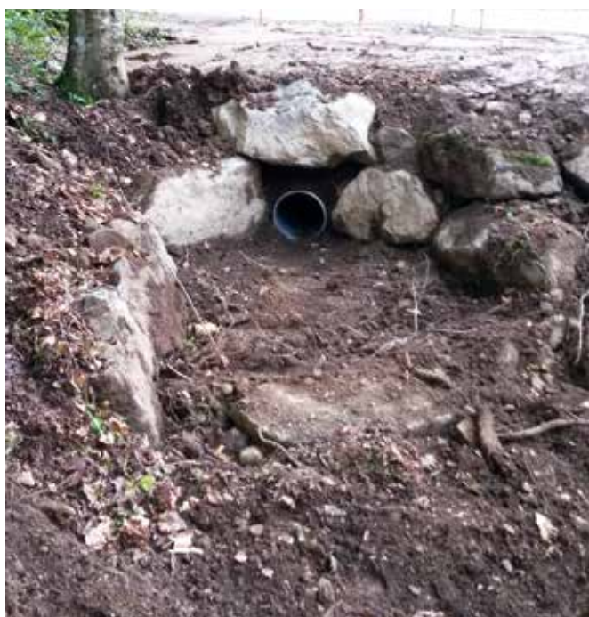
Dernière étape, la traversée de la route et le rejet de l'eau dans le fossé le long de la route, où l'eau s'infiltré.
