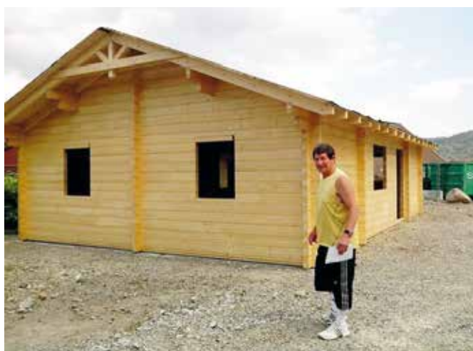
Le Club House en construction
