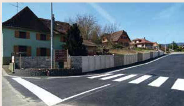
Sécurisation Piétonnière (29 mars 2021).
