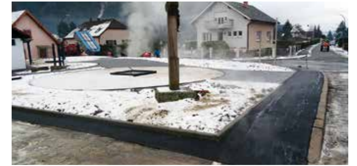
Enrobés trottoirs (Décembre 2018).
