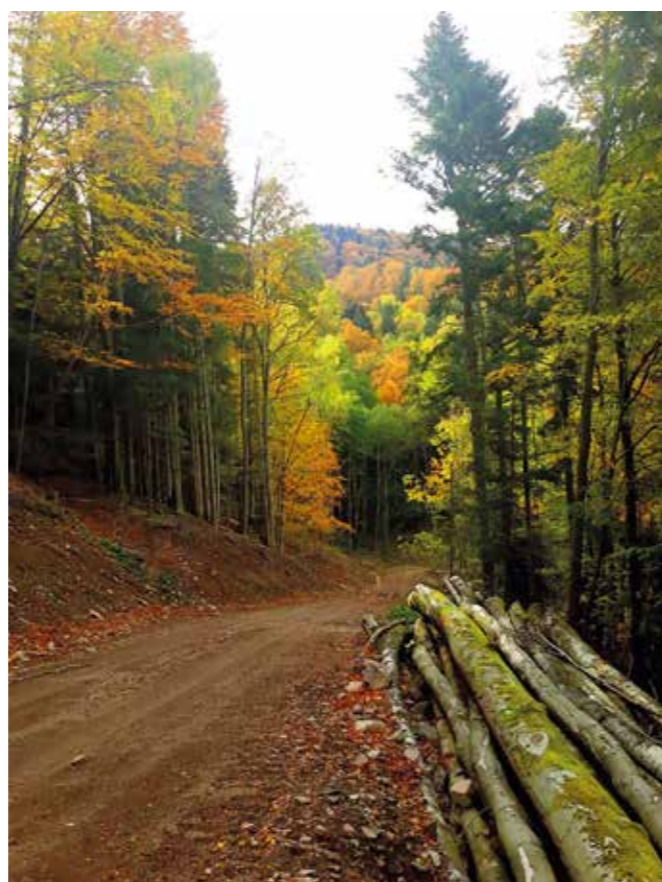
Chantier du Sprickelsberg finalisé.
